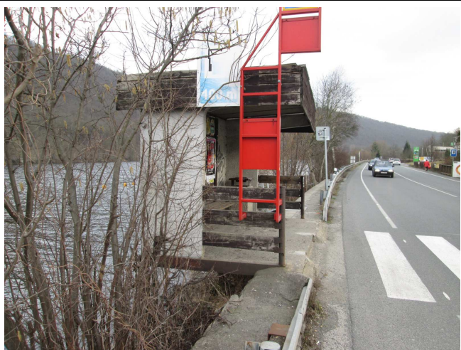
Přístřešek autobusové zastávky uložený na opěrné zdi.
