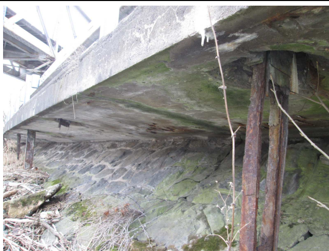
Dtto. Stopy zatékání. Bionapadení.
