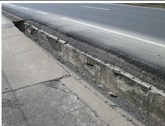
Výrazně převýšená vozovka. Masivní degradace betonu.
