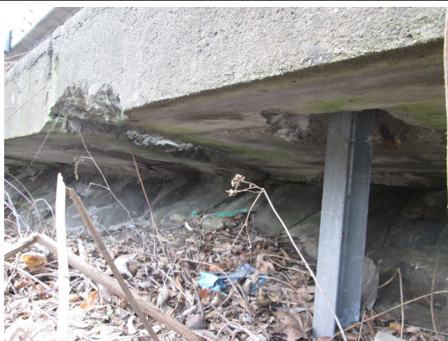
Sloupek svodidla proražený konzolou. Otevřená dilatační spára.
