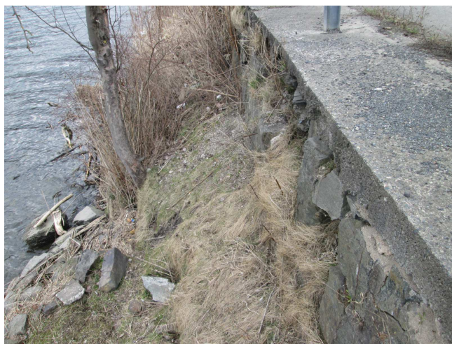
Masivně vydrolené spáry, zdivo rozvolněné.
