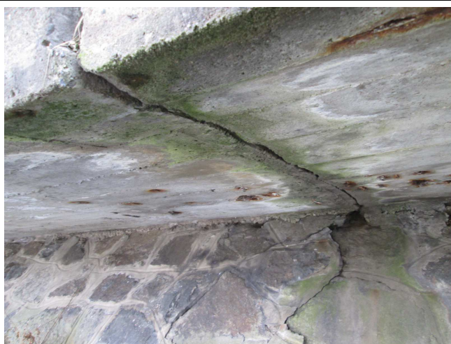
Trhlina, nebo otevřená dilatační spára. Průsaky. Bionapadení.
