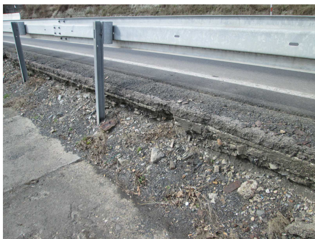
Masivní degradace betonu, rozpad. Část zdi chybí. Částečně uvolněné sloupky svodidla.
